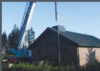
Grúas de servicio de bombas
