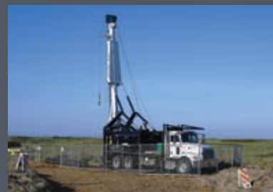
Equipos de rehabilitación y desarrollo de pozos
